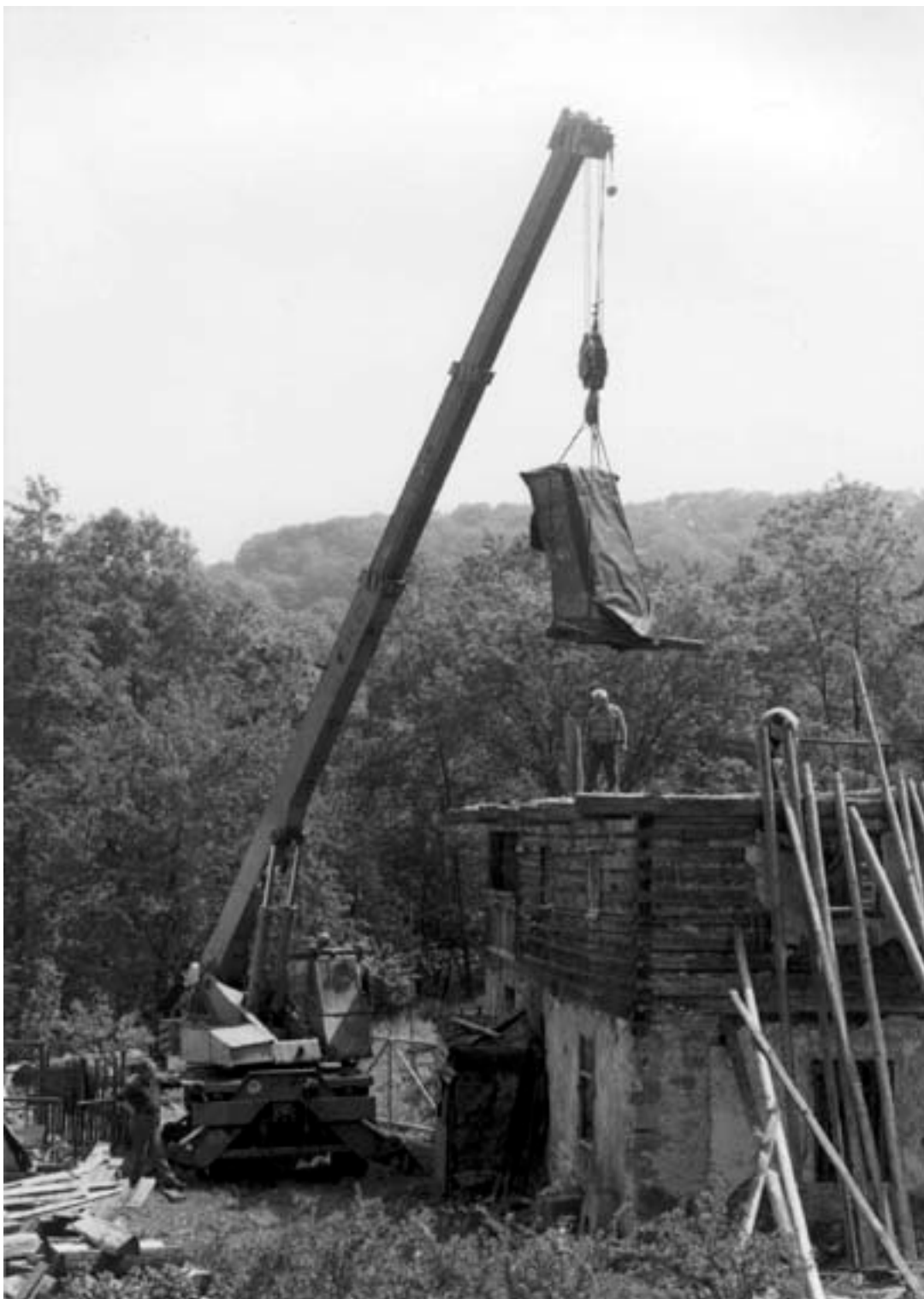
Obr. 5 - Demontáž roubeného komína. Foto F. Ledvinka, 1986.
