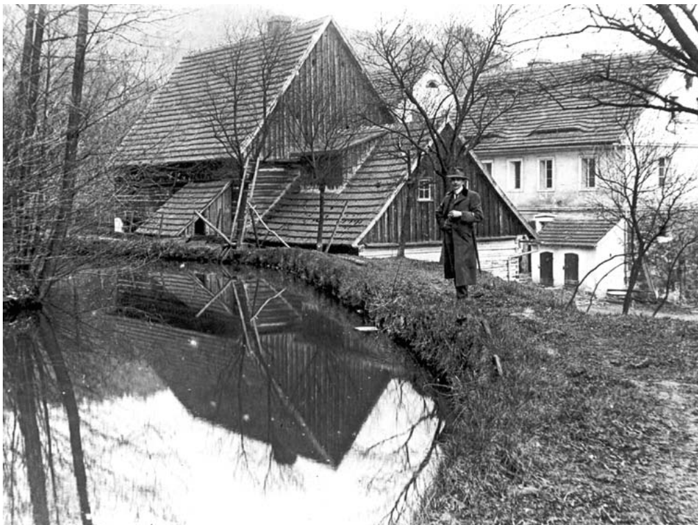
Obr. 1 - Týniště čp. 27 v roce 1917 (okres Ústí n. L. dříve okres Litoměřice). Před žebříkem u stromu vidět ovládací zařízení čepu k regulaci přítoku vody na kolo. Fotoarchiv Muzea města Ústí nad Labem.
