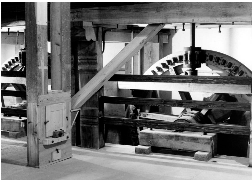
Obr. 4 - Přízemí mlýnice – palečná kola, hranice, korečkový výtah. Současný stav. Foto E. Řezáčová, 2000.
