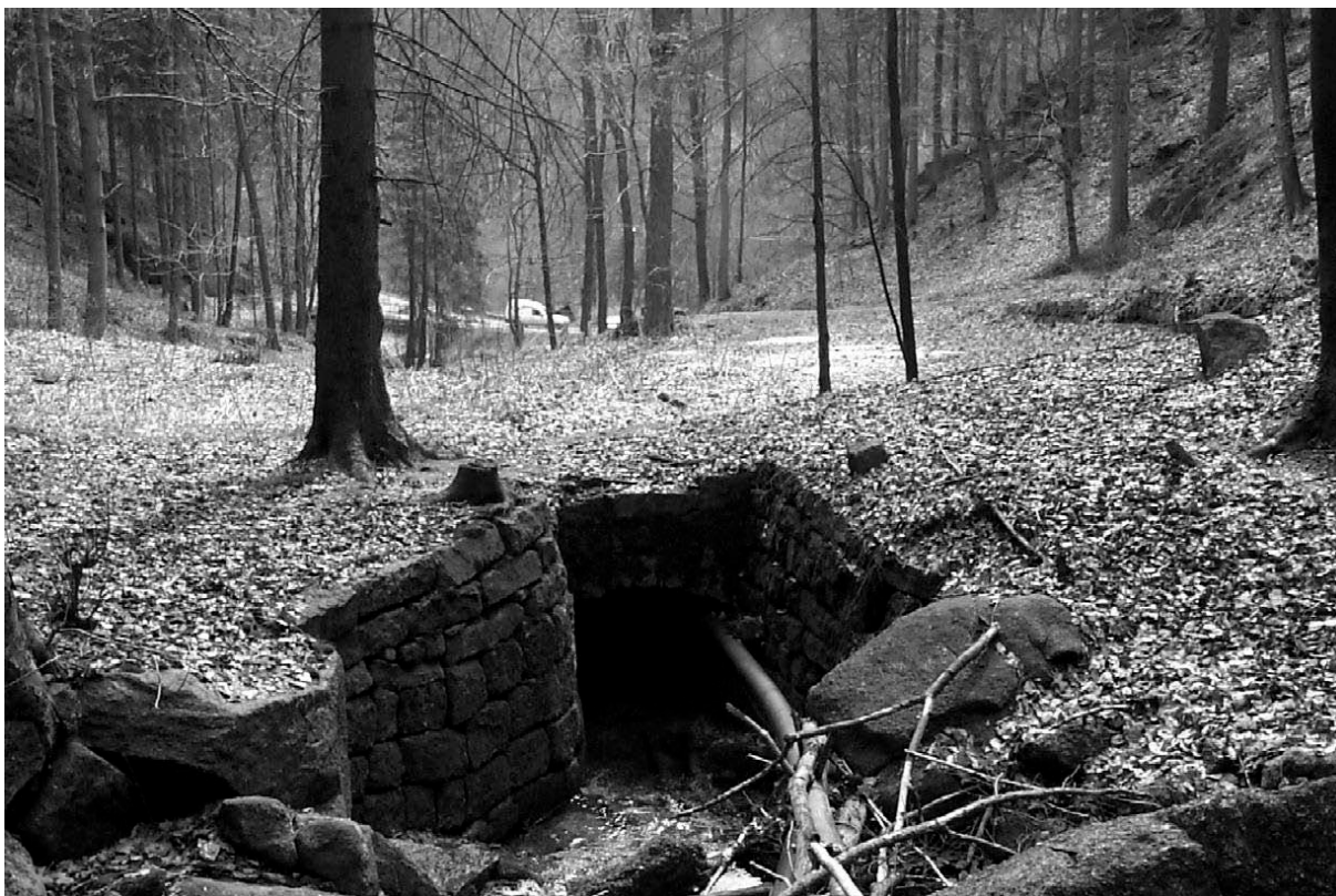
Obr. 9 - Původní řešení ponoru potoka v severní části lokality.
