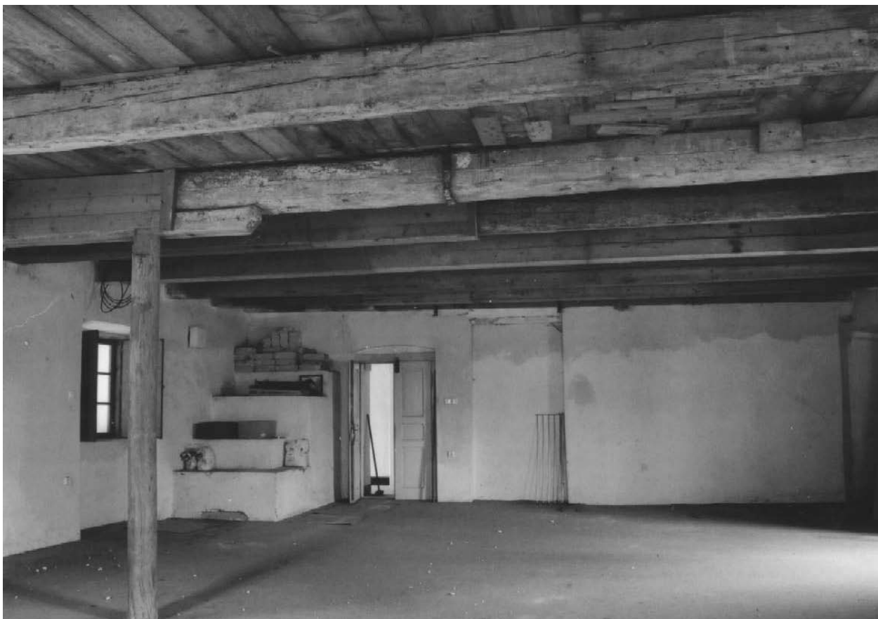
Obr. 3 - Interiér třetího podlaží mlýnice (na úrovni přízemí).
