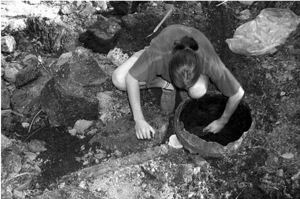
Obr. 4 - Čištění zaneseného sudu v prostoru T -koryta - vlevo roura ústící do koryta potoka.
