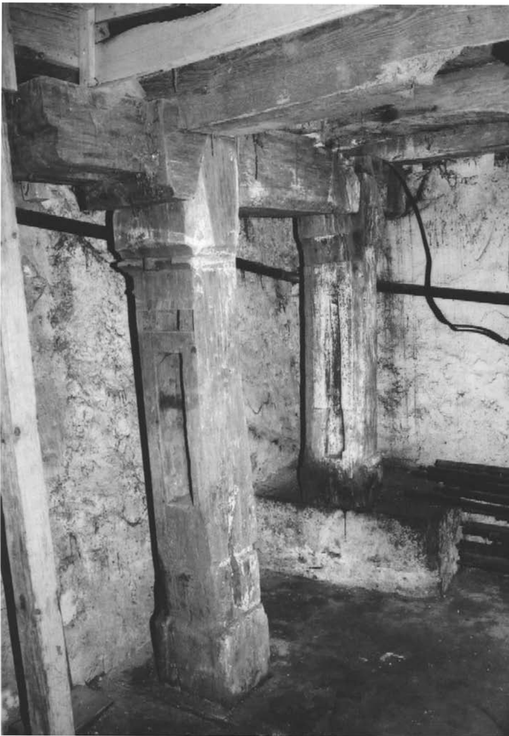
Obr. 5 - Detail východní část barokní mlýnské hranice z poloviny 18. století.
