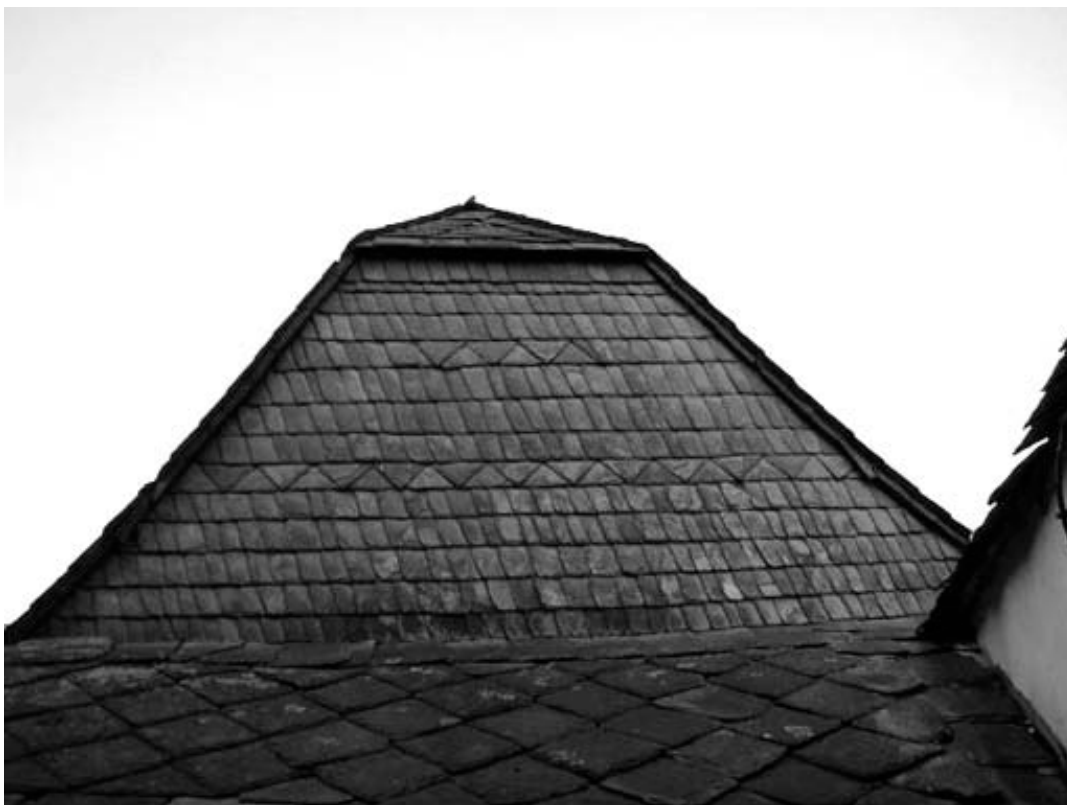
Obr. 3 - Mlýn Wesselsky, Odry – Loučky, hospodářské stavení, východní štít obložený břidlicí. Foto J. Novosad, 2002.
