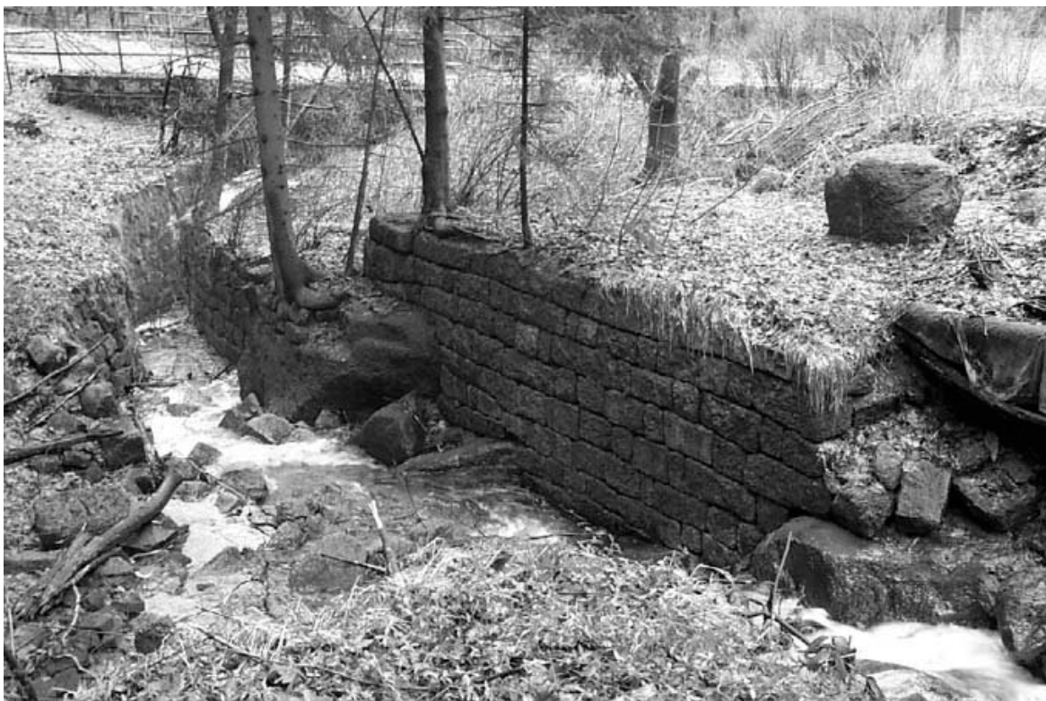
Obr. 7 - Celkový pohled na spodní jižní část.
