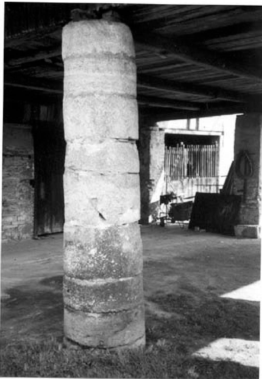
Obr. 2 – Vamberk, bývalá zájezdní hospoda čp. 603, jeden ze dvou sloupů průjezdné formanské kolny, postavených z nedokončených mlecích kamenů „vamberáků“. Foto L. Štěpán.
