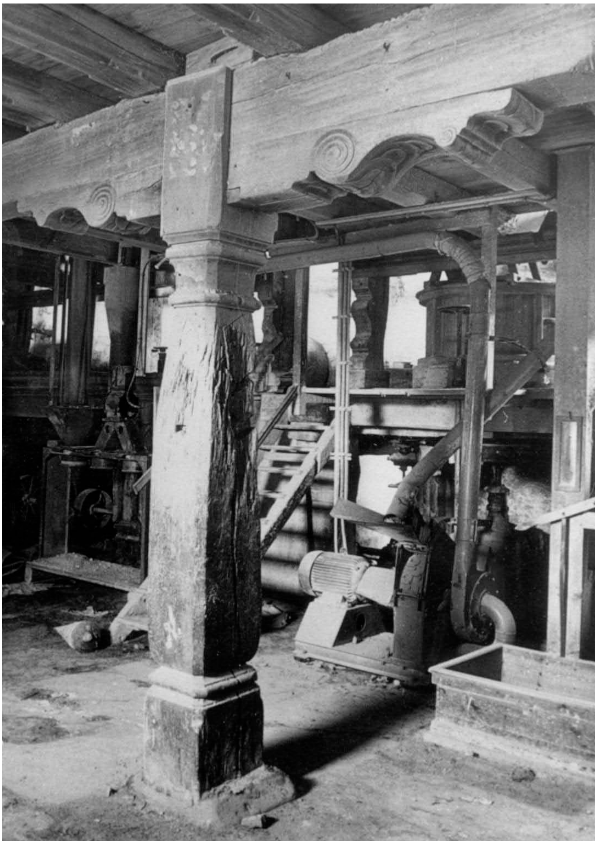
Obr. 5 - Mlýnice – nosné sloupy válcové podlahy, v pozadí hranice. Stav v roce 1974. Foto V. Uher, 1974.
