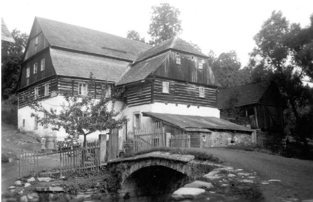
Obr. 7 - Železný Brod (okr. Jablonec n. N.), mlýn „Knopův“ (později „Adamičkův“) čp. 89. Vyhořel roku 1923, nahrazen novou zděnou stavbou. Foto B. Vavroušek, 26. 7. 1922. Archiv AV ČR Praha, Vavrouškova fotosbírka, neg. B 10634.
