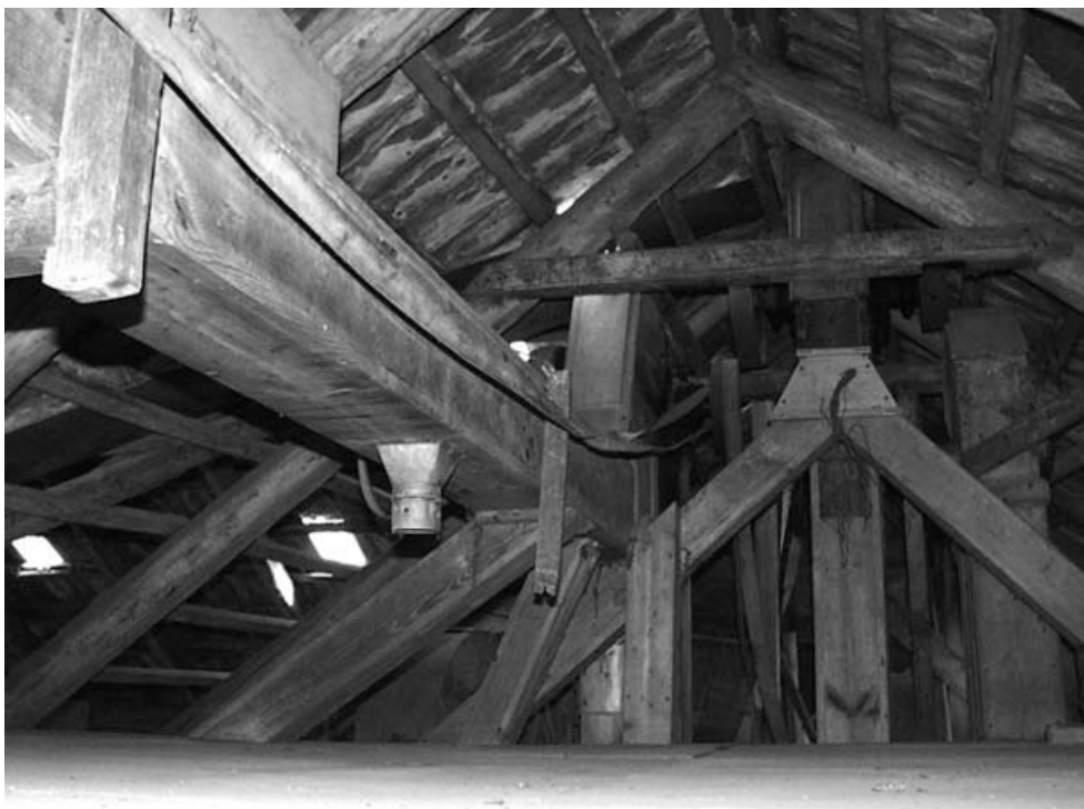
Obr. 14 - Podstřeší mlýna čp. 35 v Písečné – v pozadí je vidět dvoucestná klapka vložená do spádových trubek pod horní hlavou kapového výtahu a vlevo je vidět dřevěný žlab dopravního šneku s plechovým košíkem výpadu. Foto R. Urbánek, 2002.
