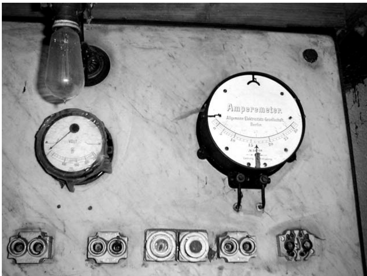
Obr. 6 - Mlýn Wesselsky, Odry – Loučky, detail mramorové rozvodové desky. Foto J. Novosad, 2002.
