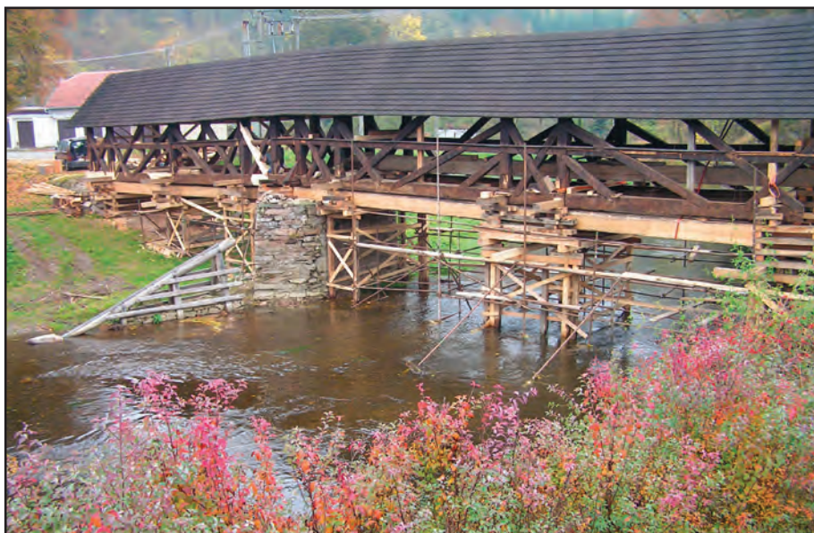
Obr. 3 Černvír (okr. Brno - venkov), podepření mostu při opravě a nový dubový ledolam. Foto Marta Procházková, 2008.
