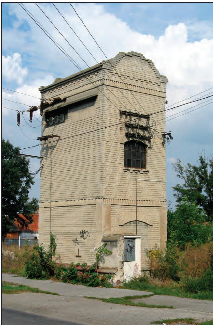
Obr. 1 Transformačná stanica v Šali, celkový pohľad. Foto Rastislav Petrovič, 2009.
