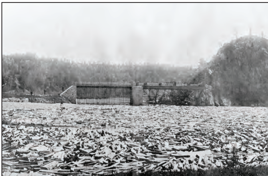
Obr. 9 Rechle (hrábě) pro zachycení volně plaveného polenového dříví. Shromaždiště na řece Mlýnský náhon poblíž obce Plava, 1900.
