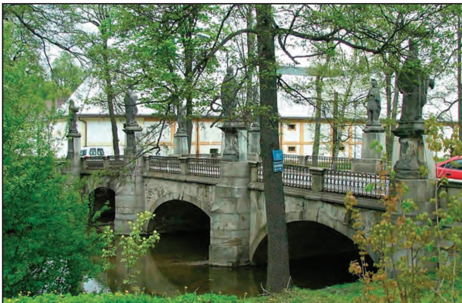
Obr. 5 Žďár nad Sázavou (okr. Žďár nad Sázavou), barokní most u zámku. Foto Tomáš Vícha, 2006.
