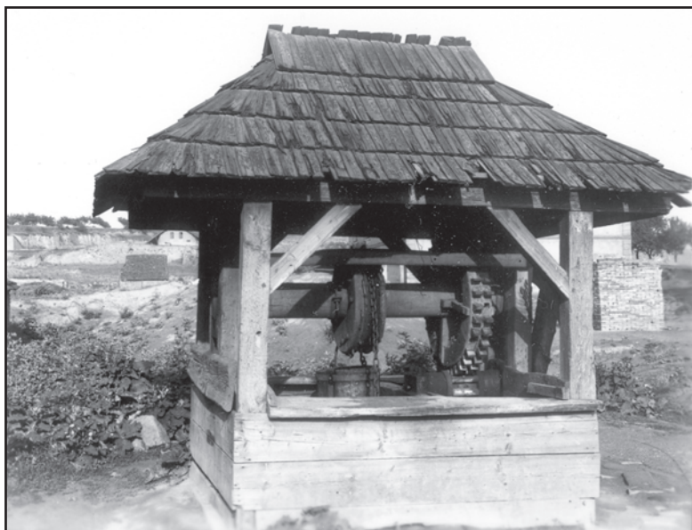
Obr. 8 Sedlec (okr. Praha-východ), krytá studna u čp. 15. Foto Bohumil Vavroušek, 1925.
