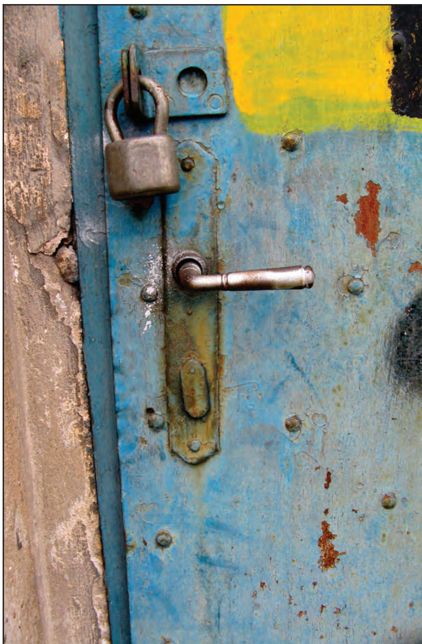
Obr. 7 Detail pôvodných vstupných dverí s kovaním a kľučkou, dvorová fasáda transformačnej stanice. Foto Rastislav Petrovič, 2004.
