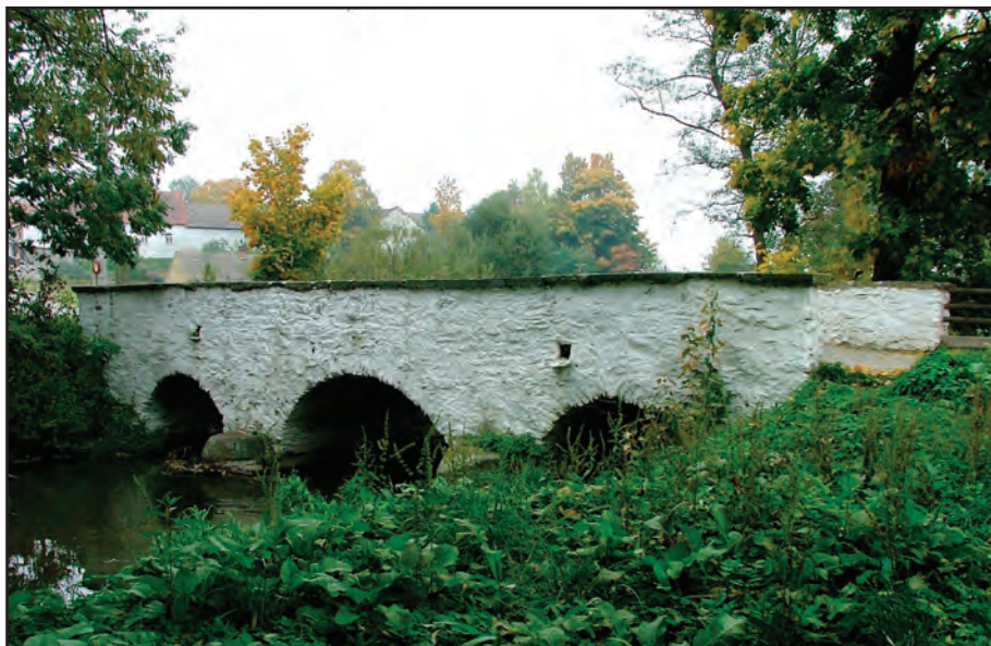
Obr. 1 Jezdovice (okr. Jihlava), kamenný most v intravilánu, první polovina 19. století. Foto Tomáš Vícha, 2004.
