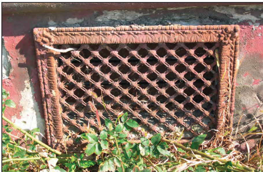
Obr. 6 Dekoratívny liatinový kryt ventilačného otvoru v sokli uličnej fasády transformačnej stanice. Foto Rastislav Petrovič, 2004.
