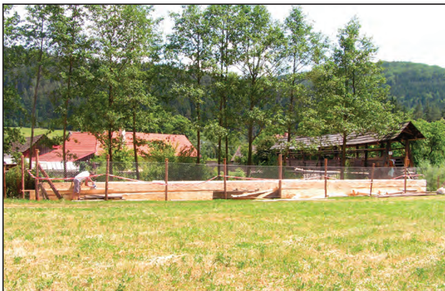
Obr. 5 Švařec (okr. Žďár nad Sázavou), opracovávání nových 25 m dlouhých nosných trámů pro lávku. Foto Marta Procházková, 2006.
