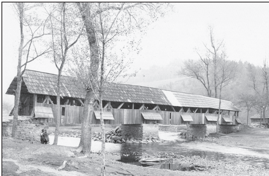
Obr. 1 Unčín (okr. Žďár nad Sázavou), dřevěný krytý most přes řeku Svatku. Foto Bohumil Vavroušek, kolem 1920.
