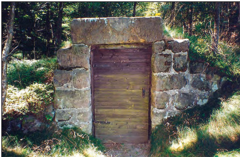
Obr. 1 Nová Skalka (okr. Česká Lípa), portál vstupu do jímky. Foto Jaroslav Jásek, 1997.
