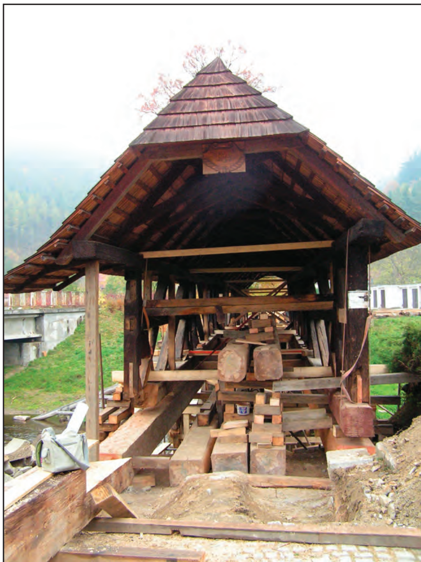
Obr. 1 Černvír (okr. Brno - venkov), průhled krytým mostem při výměně nosných trámů. Foto Marta Procházková, 2008.
