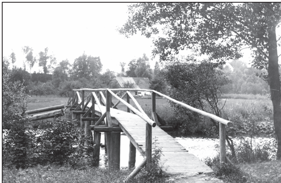
Obr. 5 Helvíkovice (okr. Ústí nad Orlicí), dřevěná lávka přes řeku Divokou Orlici. Foto Bohumil Vavroušek, 15. 8. 1924.
