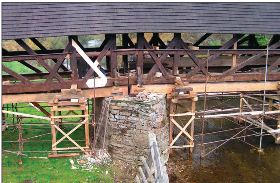
Obr. 4 Červínr (okr. Brno - venkov), výměna poškozených částí trámové konstrukce mostu. Foto Marta Procházková, 2008.
