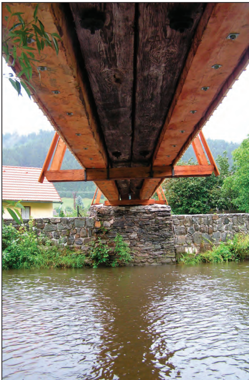
Obr. 7 Švařec (okr. Žďár nad Sázavou), pohled pod dřevěnou lávku – mezi novými nosnými trámy původní (již bez nosné funkce). Foto Marta Procházková, 2006.
