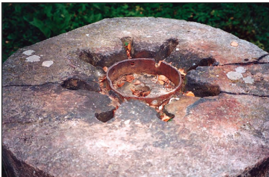
Obr. 6 Pěkná (okr. Prachatice), rozdělovač vody u statku. Detail horní části – kruhovým otvorem voda vzlíná a přetéká do osmi bočních otvorů. Foto Jaroslav Jásek, 1998.
