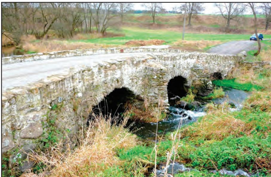
Obr. 4 Věžnice (okr. Jihlava), středověký kamenný most U Lutriána. Foto Tomáš Vícha, 2007.
