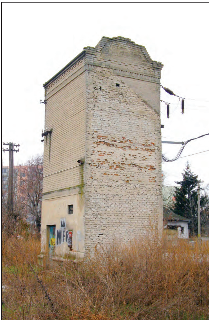
Obr. 4 Transformačná stanica, pohľad z bývalého nádvorja mlyna, stav v roku 2009. Foto Rastislav Petrovič, 2009.
