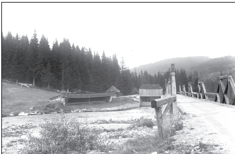
Obr. 11 Modrava (okr. Klatovy), hradlový most na řece Vydře u Rechlí se začátkem Vchynicko-Tetovského plavebního kanálu. Foto Bohumil Vavroušek, 11. 8. 1934.
