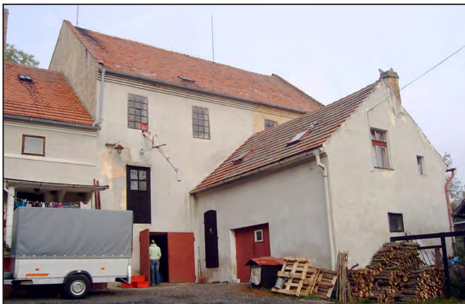
Obr. 1 Týniště (okr. Karlovy Vary), mlýn čp. 23. Celkový pohled. Foto Jan Konůpek, 2005.
