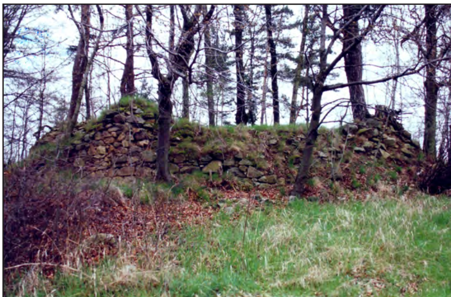
Obr. 7 Příkrakov (okr. Chrudim), torzo větrného mlýna. Velký průměr základů zdiva dokládá zdejší kombinaci pohonu větrného se žentourovým. Foto Luděk Štěpán, 2003.
