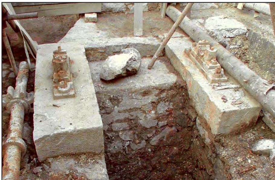
Obr. 3 Týniště (okr. Ústí nad Labem), pila u mlýna čp. 28. Ložiska převodové hřídele. Foto František Ledvinka, 2008.
