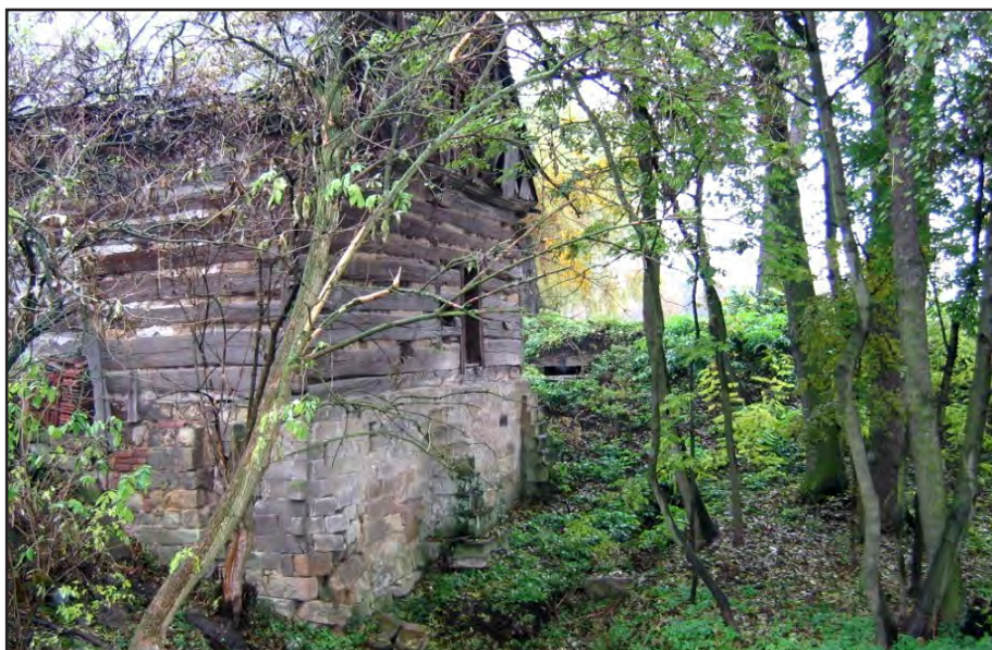
Obr. 4 Psinice (okr. Jičín), mlýn čp. 48. Návodní strana, pohled směrem k silnici, kterou „podchází“ vodní náhon. Foto Milan Smolík, 2004.
