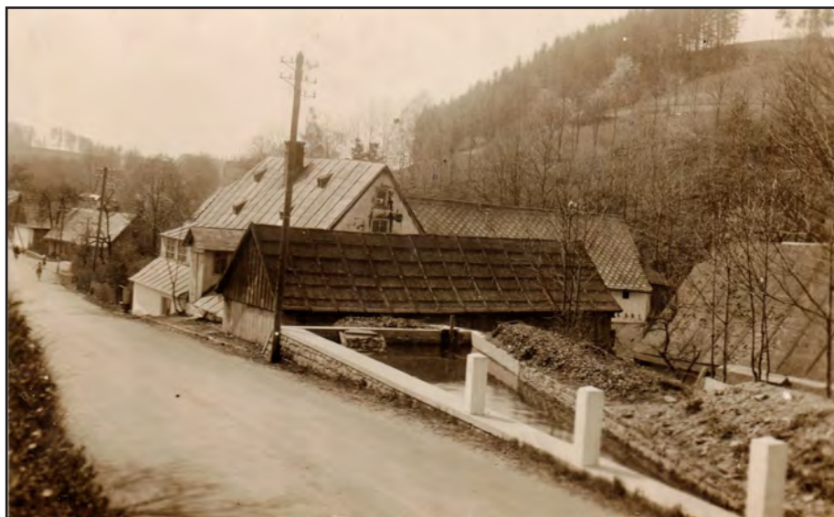
Obr. 3 Kunvald (okr. Ústí nad Orlicí), mlýn čp. 188. Stav po modernizaci ve 40. letech 20. století. Po osazení turbíny byla vybudována betonová nádržka. Foto autor neznámý, soukromá sbírka.
