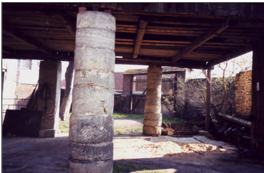
Obr. 6 Vamberk (okr. Rychnov nad Kněžnou), zájezdní hospoda čp. 603. Sloupy kolny z otesků mlecích kamenů zvaných Vamberáky. Foto Luděk Štěpán, 2000 (z průzkumu Dr. M. Bekové).
