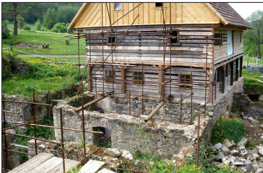
Obr. 6 Týniště (okr. Ústí nad Labem), mlýn čp. 28. Hrubá stavba mlýna z Homole - v popředí lednice pily s olejnou, za ní lednice mlýna. Foto František Ledvinka, 2008.
