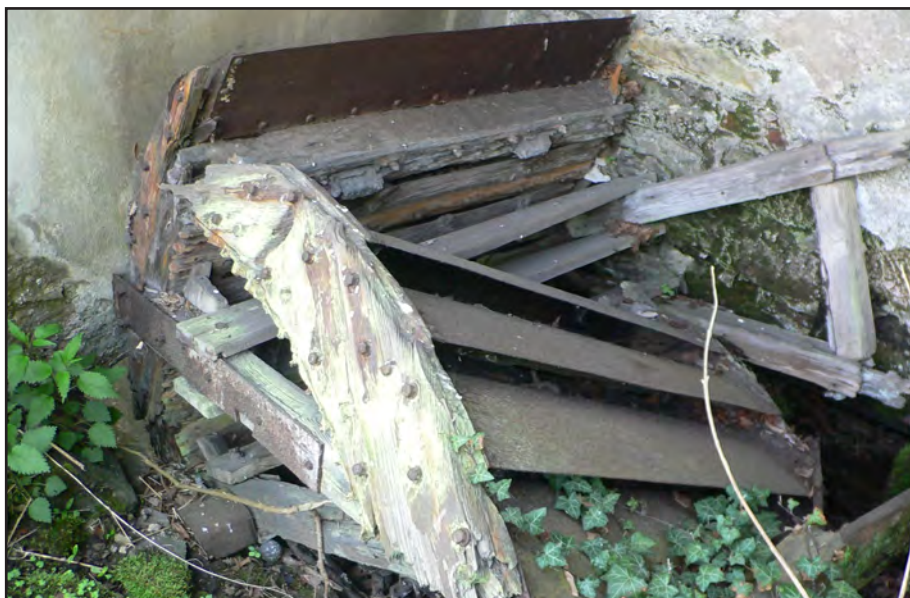
Obr. 11 Bělá pod Bezdězem (okr. Mladá Boleslav), Podzámecký mlýn čp. 322, pohled na návodní stranu s lednicí a betonovými vantroky, čelní pilíř z mlecích kamenů. Foto Miroslav Kolka, 2005.
