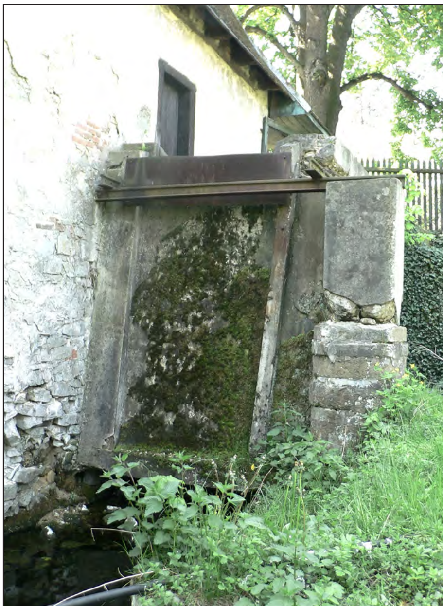
Obr. 12 Bělá pod Bezdězem (okr. Mladá Boleslav), Podzámecký mlýn čp. 322, pohled na návodní stranu s lednicí a betonovými vanatroky, čelní pilíř z mlecích kamenů. Foto Miroslav Kolka, 2005.
