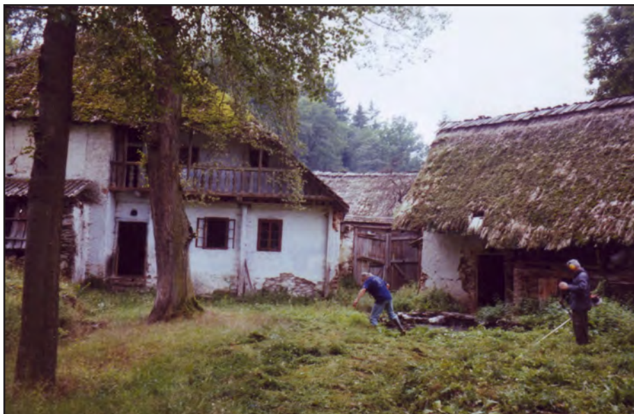
Obr. 1 Hoslovice (okr. Strakonice), vodní mlýn. Stav před zahájením rekonstrukce. Foto Luděk Štěpán, 2005.
