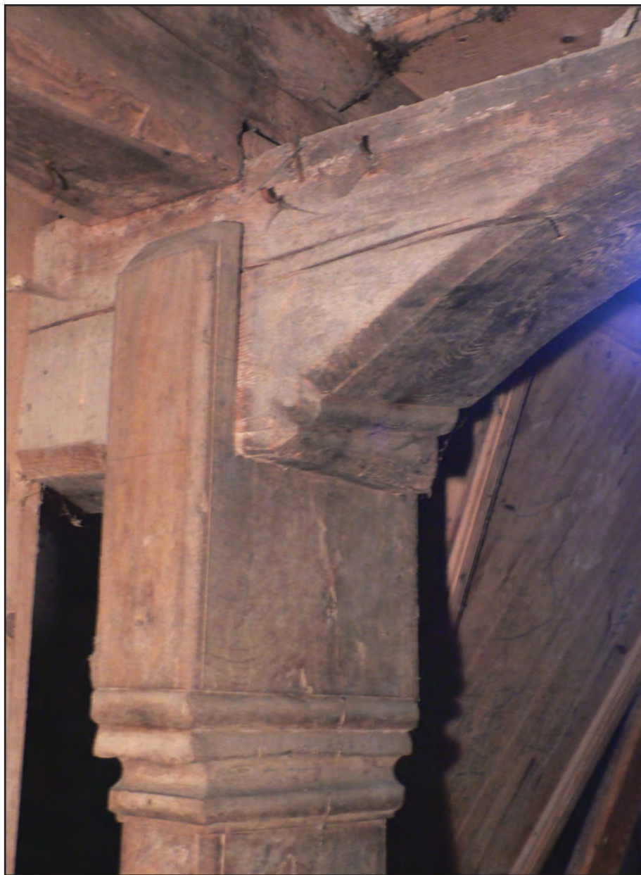
Obr. 13 Bělá pod Bezdězem (okr. Mladá Boleslav), Podzámecký mlýn čp. 322, 1. P. P. – detail mlýnské hranice ve střední části se segmentovým vykrojením nad schodištěm do 1. N. P. Foto Miroslav Kolka, 2005.
