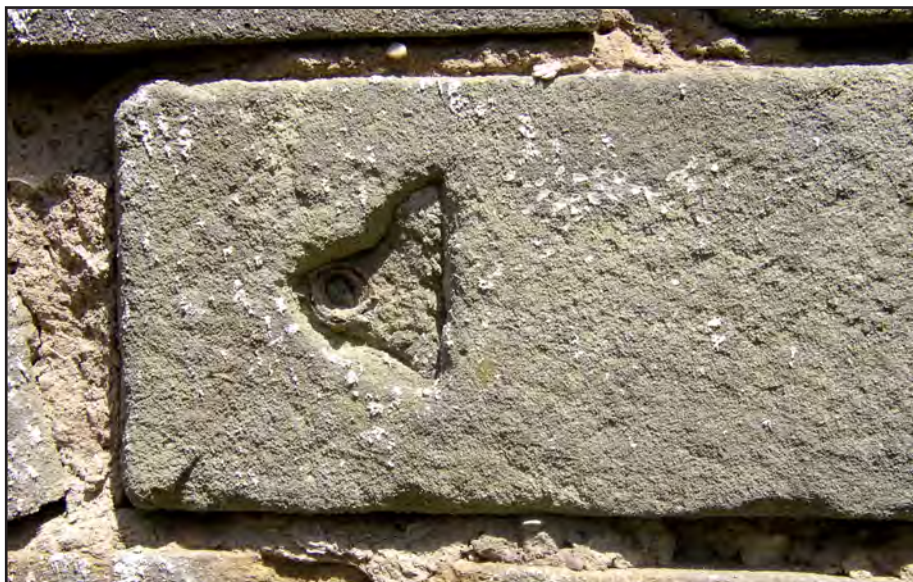
Obr. 7 České Petrovice (okr. Ústí nad Orlicí), mlýn čp. 152. Vodní cejch (druhotně použitý?) na budově mlýna. Foto Hana Klimešová, 2004.
