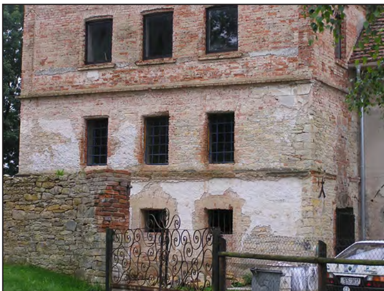
Obr. 3 Vysoké Mýto (okr. Ústí nad Orlicí), mlýn Sárovec čp. 184. Cihelné zdivo se vztahuje k přestavbě mlýna v letech 1878 a 1879. Foto Radim Urbánek, 2005.
