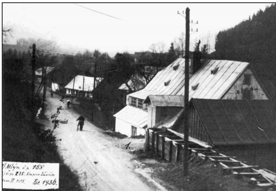
Obr. 2 Kunvald (okr. Ústí nad Orlicí), mlýn čp. 188. Stav v roce 1936, ještě s dřevěnými vantroky. Foto autor neznámý, soukromá sbírka.
