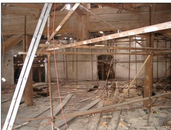
Obr. č. 10. První opravy žentouru. Foto: Milan Starec, 2006.
