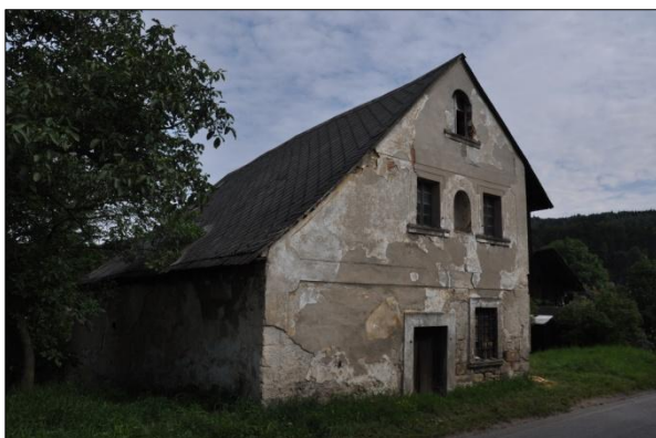
Obr. č. 5. Frýdštejn čp. 47 (JN). Pohled od jihozápadu. Foto autoři, 2011.
