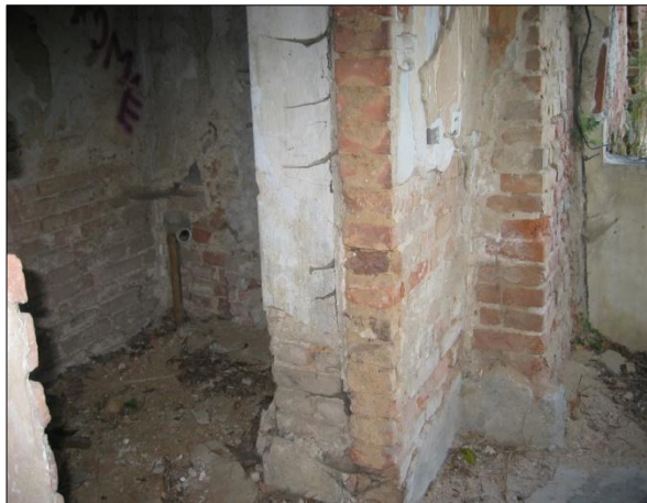
Obr. č. 17. Praha - Libeň, Pod Labuťkou č.p. 391/4, objekt s tehliarskou pecou. Pohľad od západu na zosekanú a pôvodnú časť západnej strany pece. Foto: J. Čáni, 2013.
