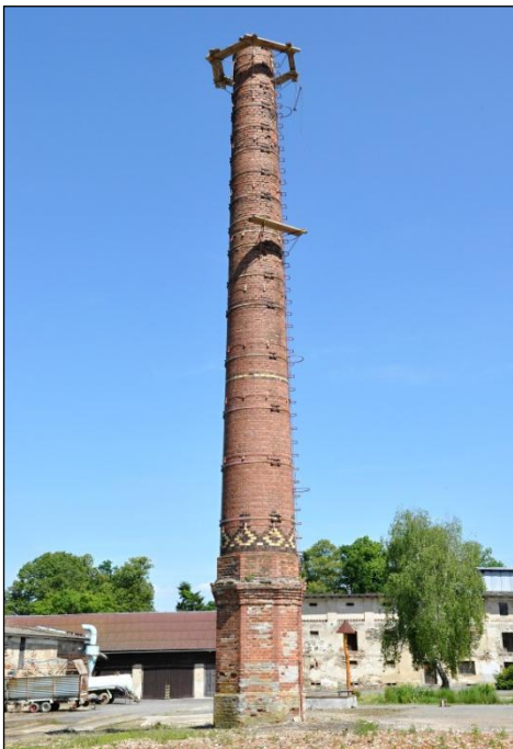
Obr. č. 3. Typický oblý komín z radiálek – lihovar Šternov (komín aktuálně čeká na demolici), foto: M. Vonka, 2013.
