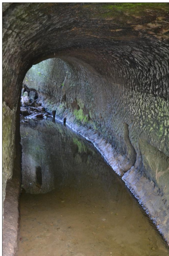
Obr. č. 13. Detail skalní štoly odtokového kanálu od vyústění směrem k lednici. Foto M. Kolka 2012.
