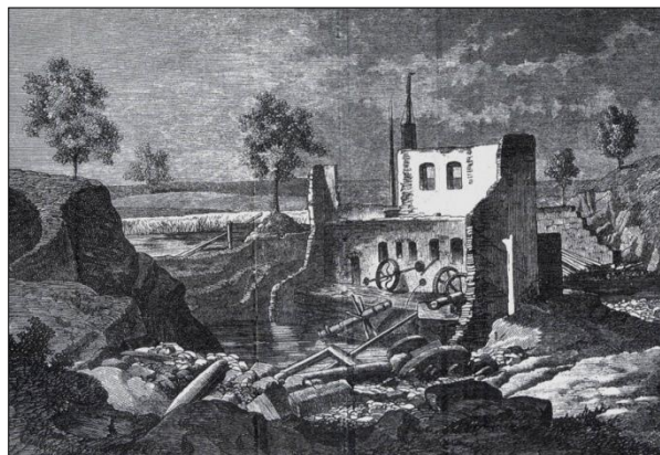
Obr. č. 12. Hugo Ullík. Zřícená parní pila ve Stebnu. Stěna ve směru proudu pod protrženou hrázi vydržela. Zachránili se na ní ve vyšších dvou oknech dva lidé.
