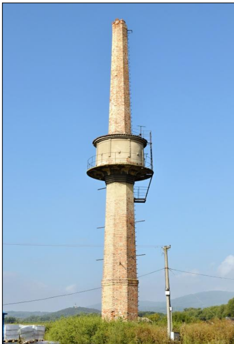
Obr. č. 3. Typický oblý komín z radiálek – lihovar Šternov (komín aktuálně čeká na demolici), foto: M. Vonka, 2013.
