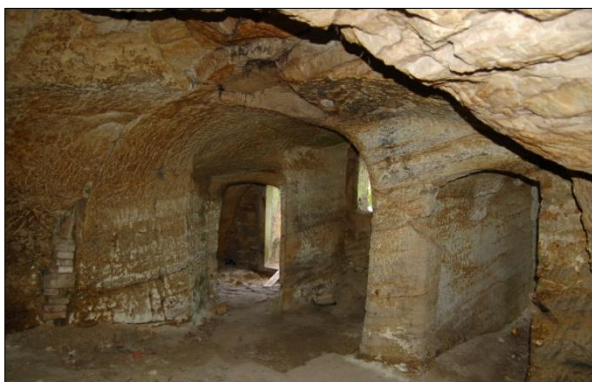
Obr. č. 6. Interiér zadního chléva zahluobeného do pískovcového podloží, vpravo dveřní otvor spojovací chodby s domem, vlevo dveřní otvor do předního chléva se samostatným vstupem. Foto M. Kolka 2012.
