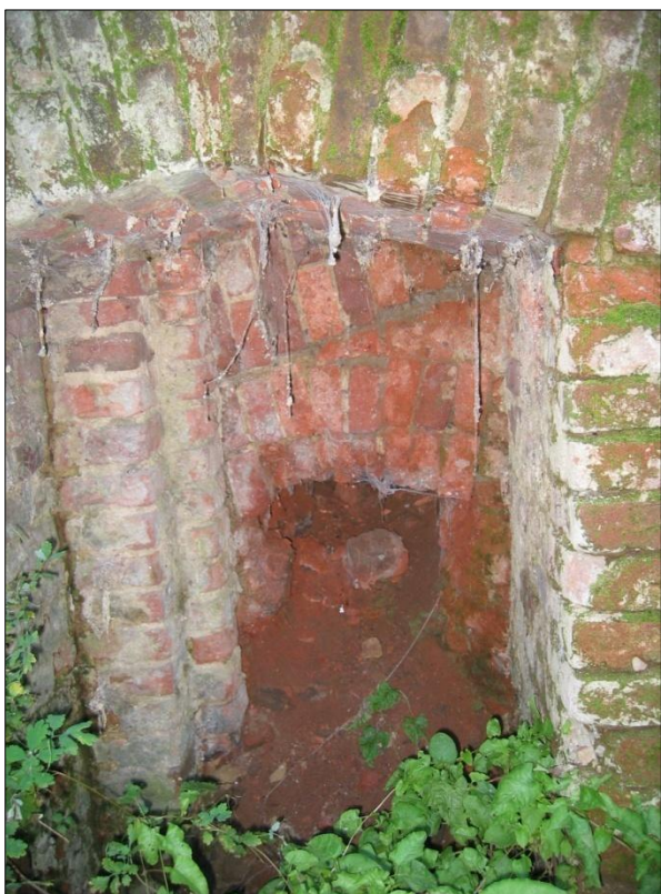
Obr. č. 9. Praha - Libeň, Pod Labuťkou č.p. 391/4, objekt s tehliarskou pecou. Pohľad do južnej manipulačnej niky s otvorom na prikladanie paliva a nábehu oblúka predpokladaného roštu. Foto: J. Čáni, 2013.
