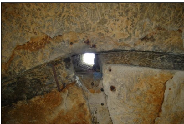
Obr. č. 22. Detail dráží ve stropu dílny pro uchycení kastlíku jednotlivých kouřovodů se společným komínovým vyústěním. Foto M. Kolka 2012.
