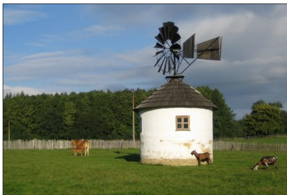
Obr. č. 6. Jindřichovice pod Smrkem 12 (LI). Foto J. Doubek, 2013.
