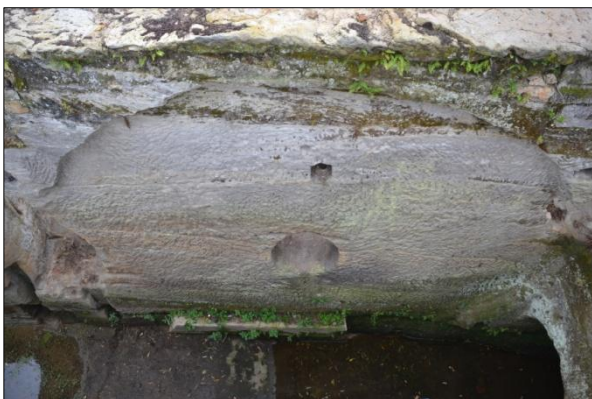
Obr. č. 10. Skalní stěna vydělující lednici od výrobního prostoru s přisekaným ústupkem kopírujícím průběh vodního kola, uprostřed otvor pro vstup hřídele k převodovému soustrojí. Foto I. Peřina 2012.
