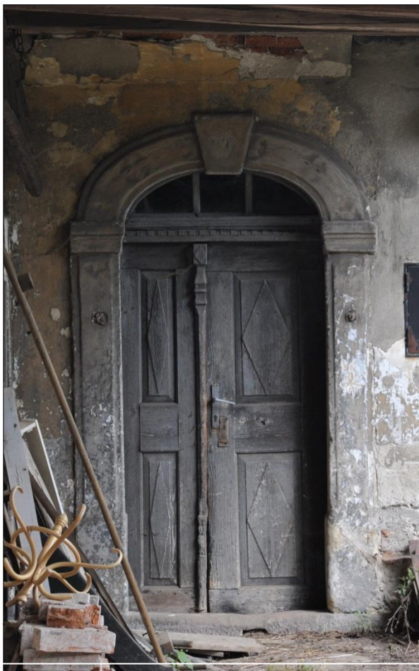
Obr. č. 8. Frýdštejn čp. 47 (JN). Hlavní vstup. Foto autoři, 2011.
