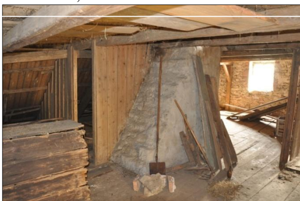
Obr. č. 10. Frýdštejn čp. 47 (JN). Těleso dymníku nad černou kuchyní. Foto autoři, 2011.
