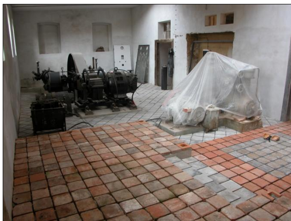
Obr. č. 18. Strojovna. Foto: Milan Starec, 2010.
