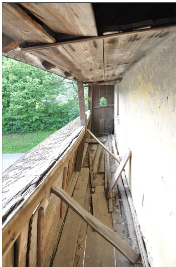
Obr. č. 7. Frýdštejn čp. 47 (JN). Pohled na pavlač. Foto autoři, 2011.
