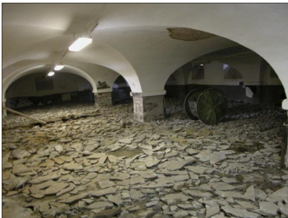
Obr. č. 8. První betony. Foto: Milan Starec, 2004.
