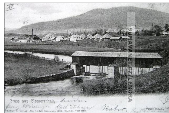
Obr. č. 4. Rechle Lenore, funkční stav. Na obrázku je zřejmý systém svislých tyčí a základ sestavovaného voru. Pohlednice z r. 1902, zdroj: www.sumavanet.cz/lenora .
