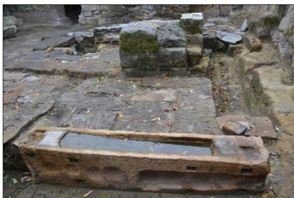
Obr. č. 20. Detail pravého kamenného štoku, v podlaze za ním jáma pro paleční kolo. Foto I. Peřina 2012.
