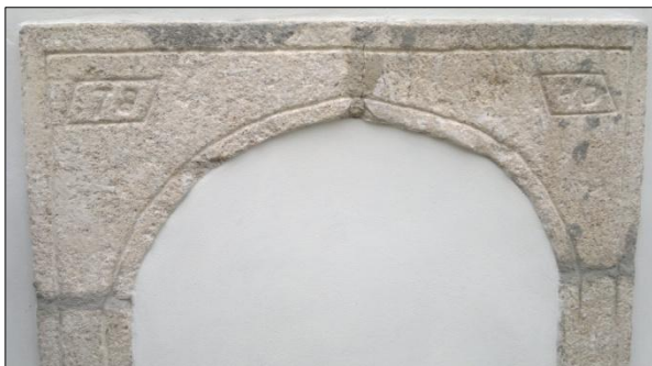
Obr. č. 8. Josefův Důl (okres Jablonec nad Nisou), brusírna čp. 865, původní vstupní portál datovaný rokem 1840. Foto: David Veverka, 2010.
