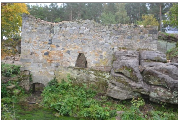
Obr. č. 12. Severozápadní průčelí s otvorem pro zhlaví hřídele a vlevo s klenutým otvorem jalového přepadu. Foto I. Peřina 2012.
