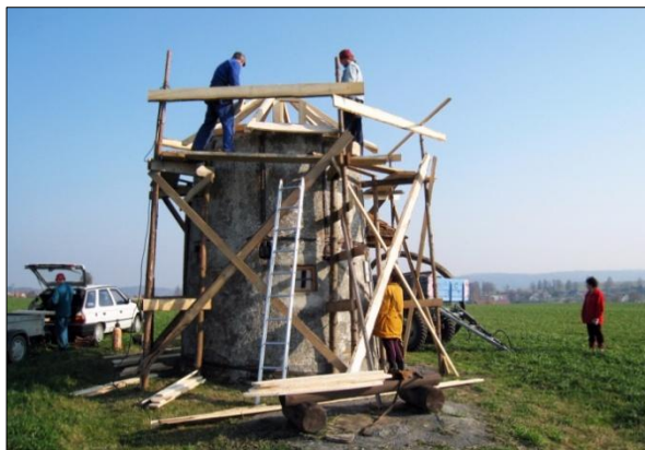
Obr. č. 6. Nová střecha mlýna. Foto J. Doubek, 2008.
