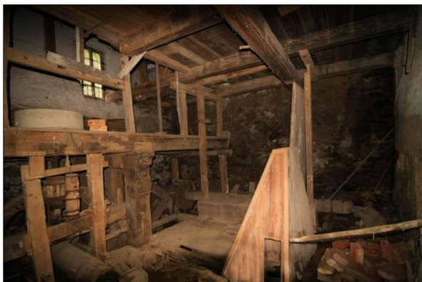
Obr. č. 13. Pohled do mlýnice Párisova mlýna čp. 6 u obce Nedvězí (BN). Za násypkou téměř dochovaná tyčová stoupa s hnacím ústrojím. Foto R. Šimek, 2012.
