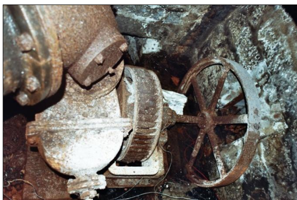
Obr. č. 13. Karlov (okres Jablonec nad Nisou), brusírna čp. 65, Schwamkrugova turbina s odejmutým vrchním krytem, vidět je zde oběžné kolo. Foto: David Veverka, 2008.
