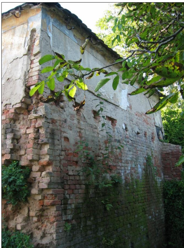
Obr. č. 11. Praha - Libeň, Pod Labuřkou č.p. 391/4, objekt s tehliarskou pecou. Pohľad od juhovýchodu na čelo pece nad obslužnou jamou. Foto: J. Čáni, 2013.
