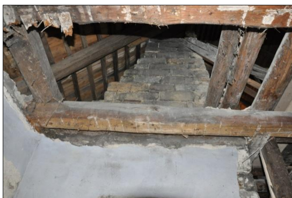
↑ Obr. č. 15. Frýdštejn čp. 47 (JN). Pas vynášející dymník výhně. Foto autoři, 2011.
