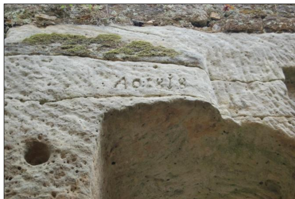
Obr. č. 11. Detail datace A O: 1818 nad vstupem ze stoupy naproti jalovému přepadu. Foto M. Kolka 2012.
