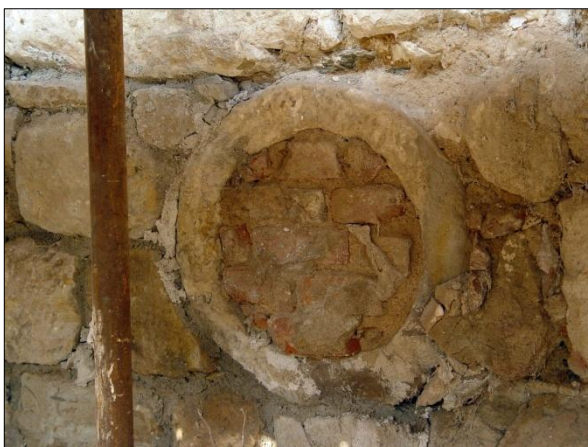
Obr. č. 8. Štok zazděný v jižní zdi obytné části Satranova mlýna ve Vepřku čp. 19 (ME), Foto R. Šimek, 2011.
